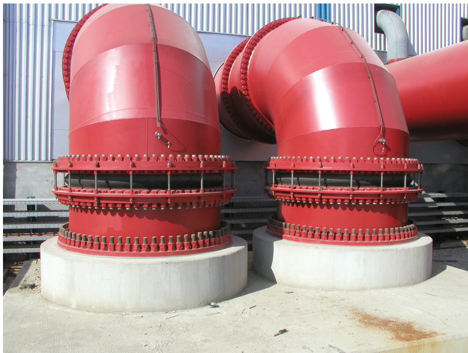
Kompensatory DN 2600 z ogranicznikami ruchu w wykonaniu M.
